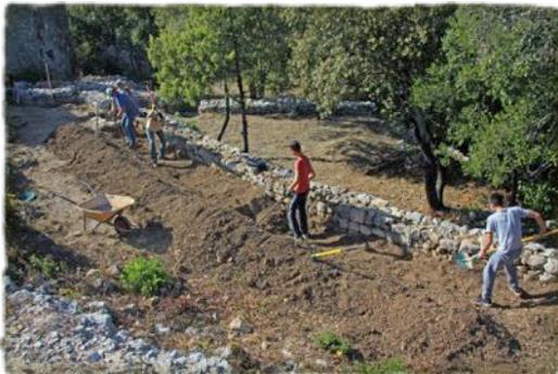
La première partie du travail, supervisée par Lionel, a consisté à creuser une tranchée d'un peu plus d'un mètre de large, d'une dizaine de mètres de long, sur cinquante à soixante centimètres de profondeur.
